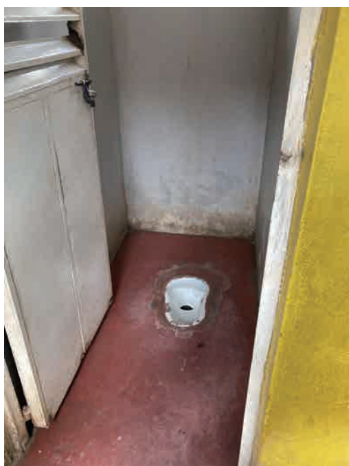
写真⑫ トイレの中の様子
