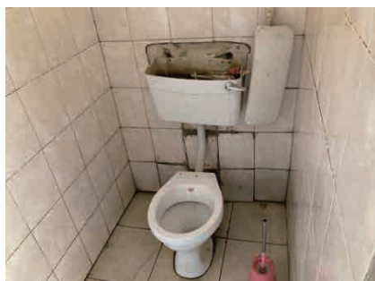
写真⑦ バイオトイレの建屋
