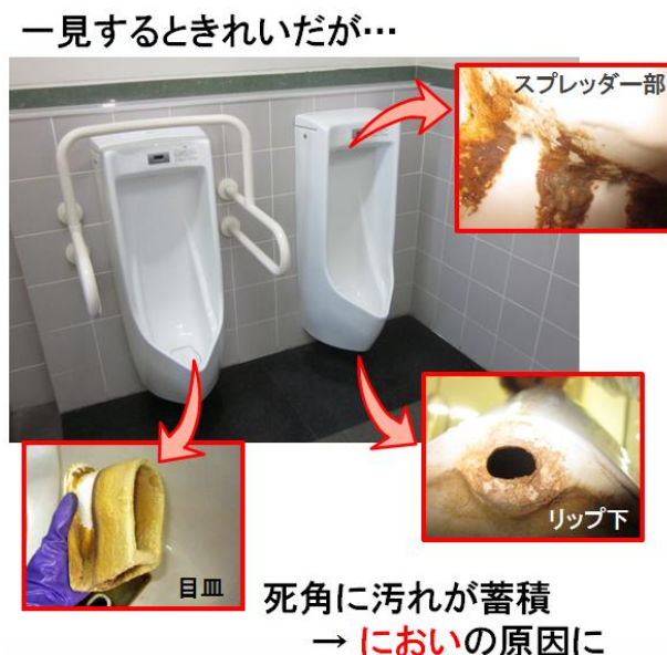
写真3 清掃状況の確認（小便器の尿石汚れ）
