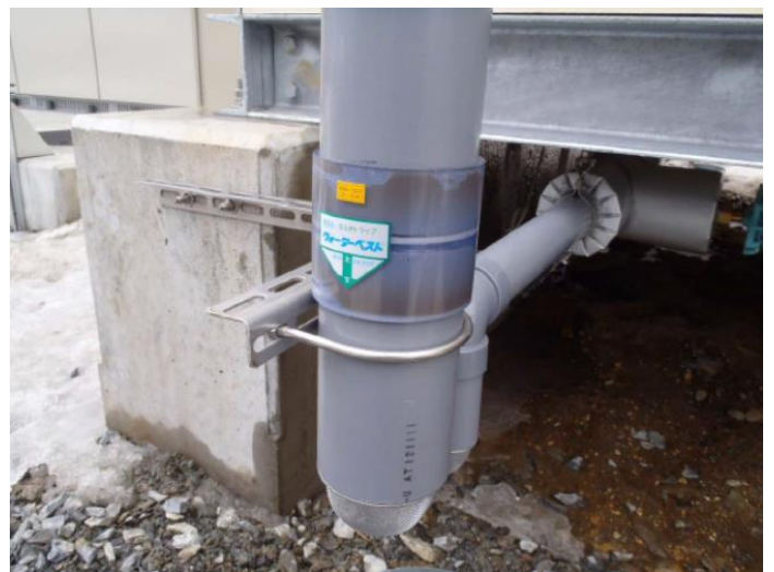
写真-1 溢水管にドレントラップを設置した例 （株式会社ユアテック 資料）
