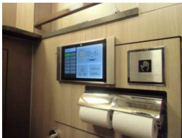
図4. 試行設置状況
