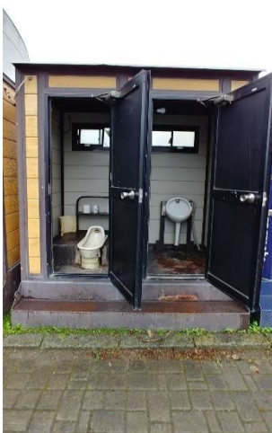
屋外仮設トイレ
