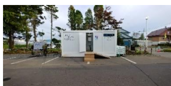
安平町地区公民館設置
