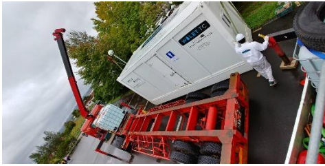
厚真町スポーツセンター搬入
