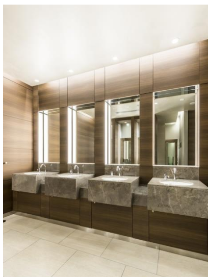
六本木ヒルズ内の改修した手洗い (素材により清掃性の向上)
