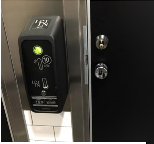
スウェーデン・ストックホルムのショッピングモールのトイレ。コインを投入すると扉が開く。
