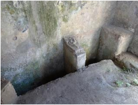
南壁：右の出入口手前の円形のくぼみと 下水溝への切り込みに注目（池口氏提供）
