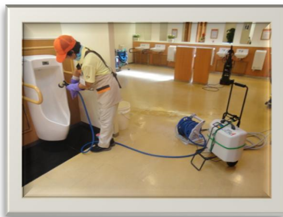
東名高速道路 海老名SAのオゾン水による清掃
