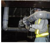
検証の污水配管
