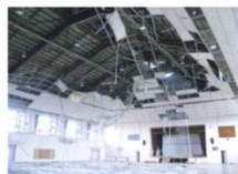
体育館吊り天井の落下
